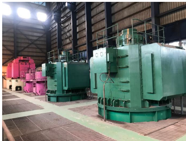
Hình 1.8. Trạm bơm nước tuần hoàn
