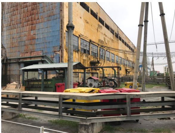
Hình 3.41. Hình ảnh khu lưu chứa CTR công nghiệp thông thường
