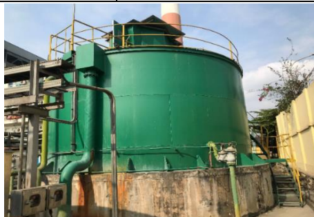
Bể lắng nước cấp
