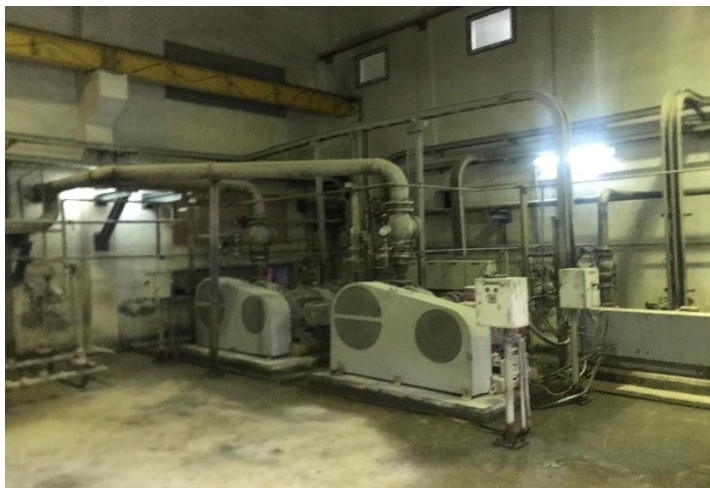
Hình 3.9. Hệ thống bơm thải xi của nhà máy
