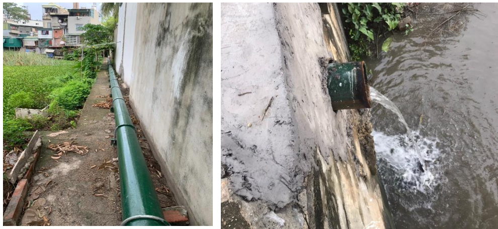
Hình 3.12. Đường ống nối qua hồ trung gian và cửa xả số 1 ra sông Uông
