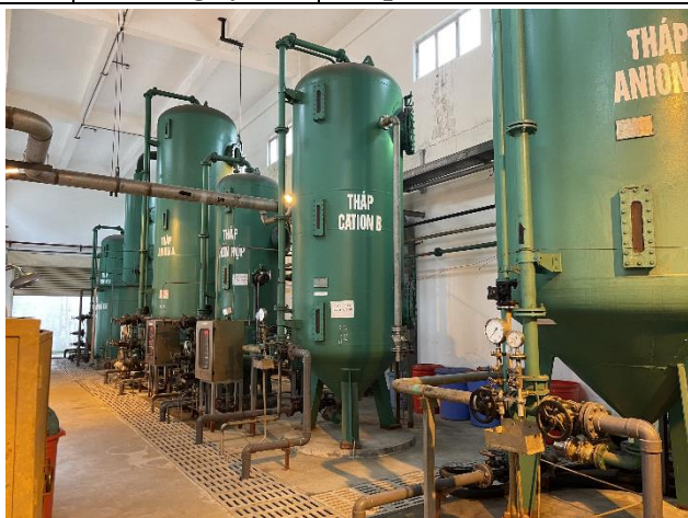
Hệ thống tháp anion và cation
