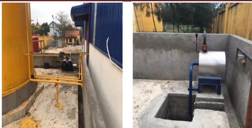
Hình 3.44. Hình ảnh rãnh chống tràn dầu
