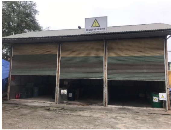
Hình 3.42. Hình ảnh kho CTNH của nhà máy
